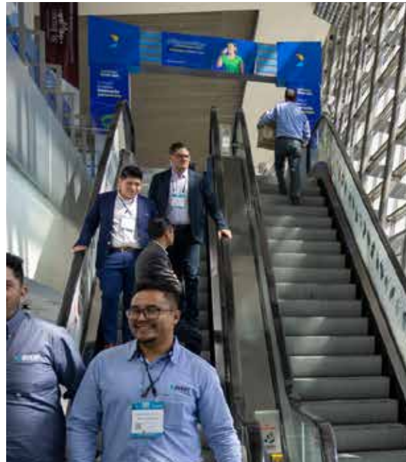
Arco en escaleras eléctricas
