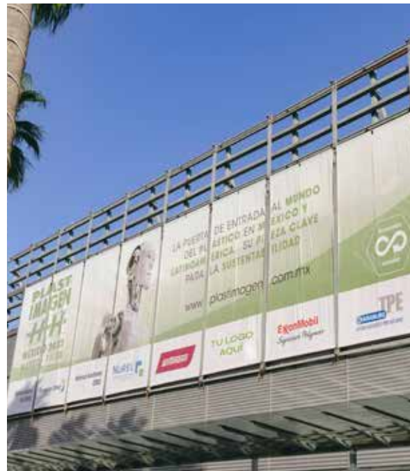
Manta exterior en fachada
